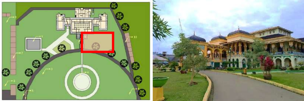
Gambar 4.19 Denah lokasi (1) sisi kanan bangunan Istana Maimun (2)
