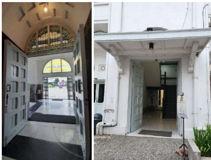
Gambar 4.98 Pintu depan (1) dan pintu samping Entrance Pos Bloc (2)
