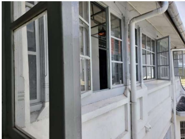
Gambar 5.45 Jendela di pos Bloc
