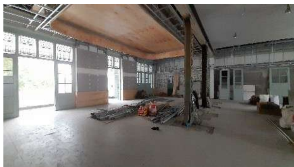
Gambar 4.121 Area lt.2 Pos Bloc yang belum rampung
